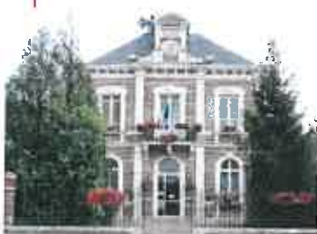
Janvier : SIABA - Maizières La Grande Paroisse - début des travaux
