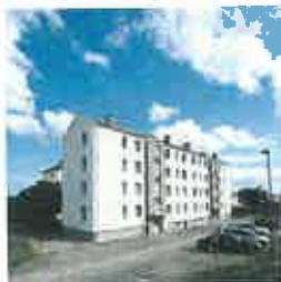
Mai : Réhabilitation de 16 logements - rue de Verdun à Saint André les Vergers
