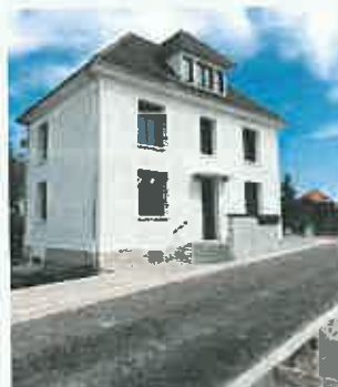
Ecole maternelle de Creney-près-Troyes en cours de rénovation
